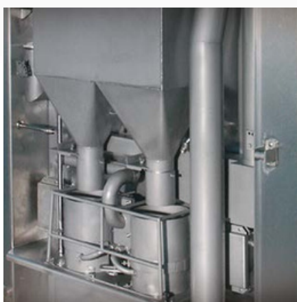
Fumée par combustion de copeaux
